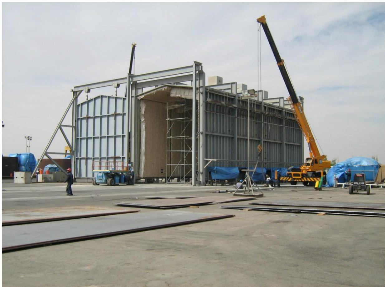
*Four LPG 9.4MW- 950°C 24mx8,5mx9m à double porte remis en état pour le traitement après soudage des structures jusqu'à 260T (PWHT).*
